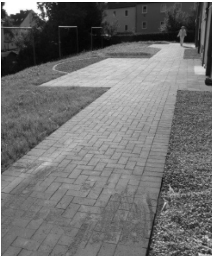
Die Zuwegungen der Grundstücke werden verbreitert, und erhalten einen einheitlichen Belag aus anthrazitfarbenen Rechteckpflaster.
